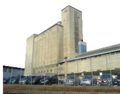
silo de la Praille
