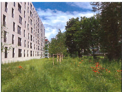
Immeuble IEPA géré par imad chemin Daniel-Ihly 21 82 logements HLM-LUP + 1 logement concierge Construction FCIL
