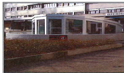
Immeuble 80 bis avenue des Communes-Réunies Local sport Construction FCIL
