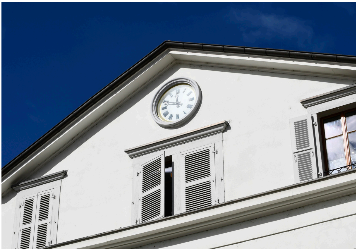
Le parc immobilier de la Ville de Lancy se compose de 79 allées, réparties sur 21 groupes d'immeubles locatifs | © Alain Grosclaude
