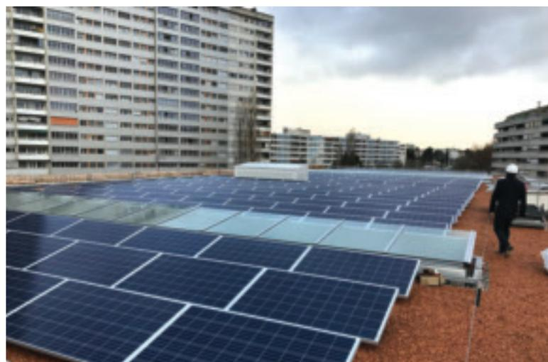
Installation de panneaux solaires photovoltaïques sur la toiture de l'Espace Palettes.
