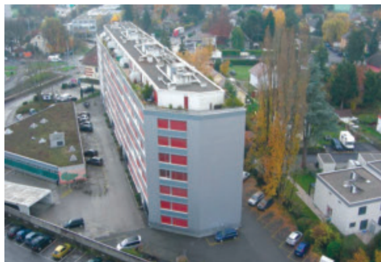
Bâtiment de la FCIL à l'avenue des Communes-Réunies.
