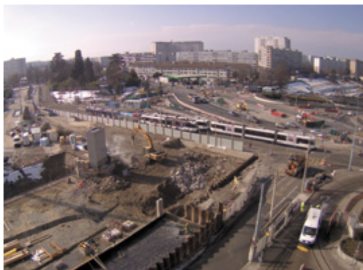
La nouvelle phase de travaux CEVA sur la route de Saint-Julien a débuté le lundi 18 février 2013.
