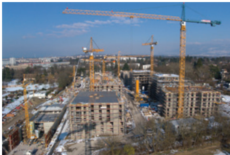
Vue panoramique du quartier depuis le haut d'une grue.
