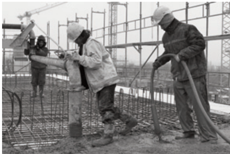
En février dernier, le gros-œuvre de La Chapelle était quasiment terminé.
