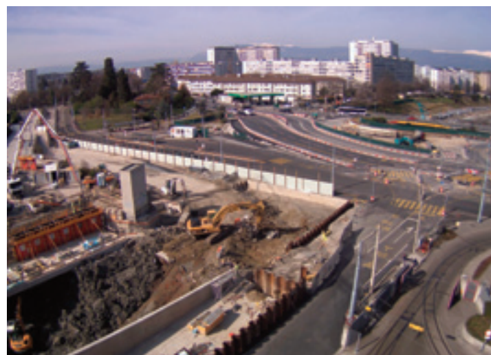
Etat des travaux CEVA au 22 mars 2013, au Bachet.
