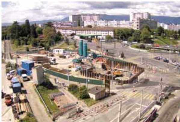
Photographie des travaux de Carouge-Bachet - 16.05.2012 à 12h15
