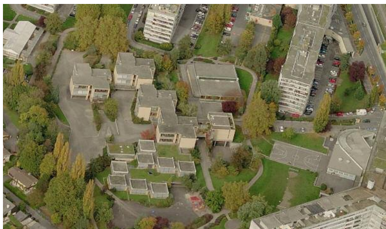
Vue aérienne du complexe de l'Ecole des Palettes
