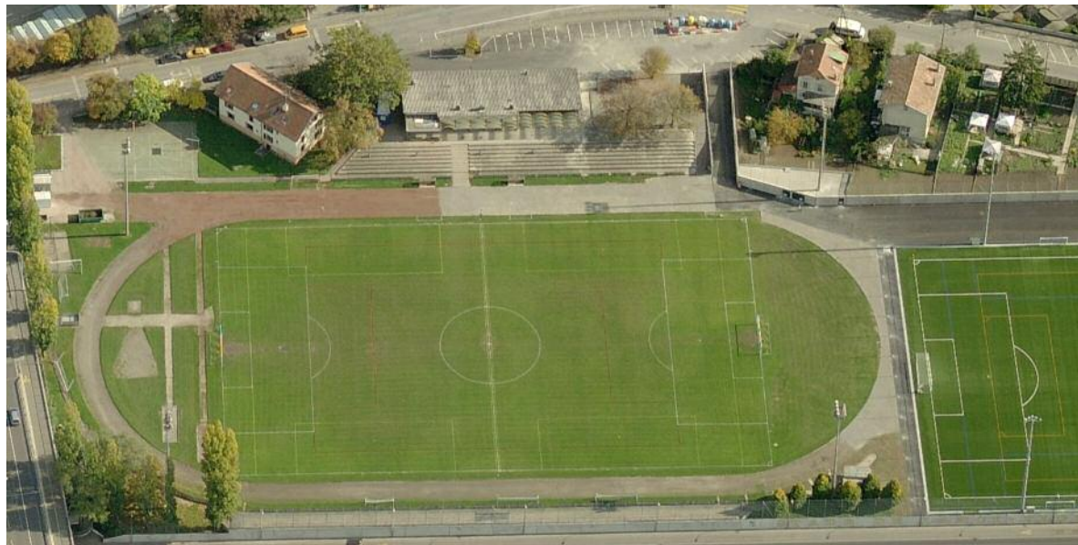
Vue aérienne du stade de Florimont
