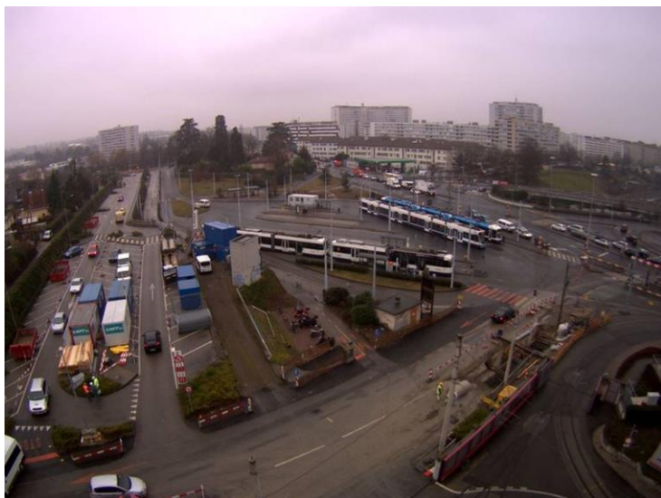
Bachet avant les travaux d'aménagement de l'interface
