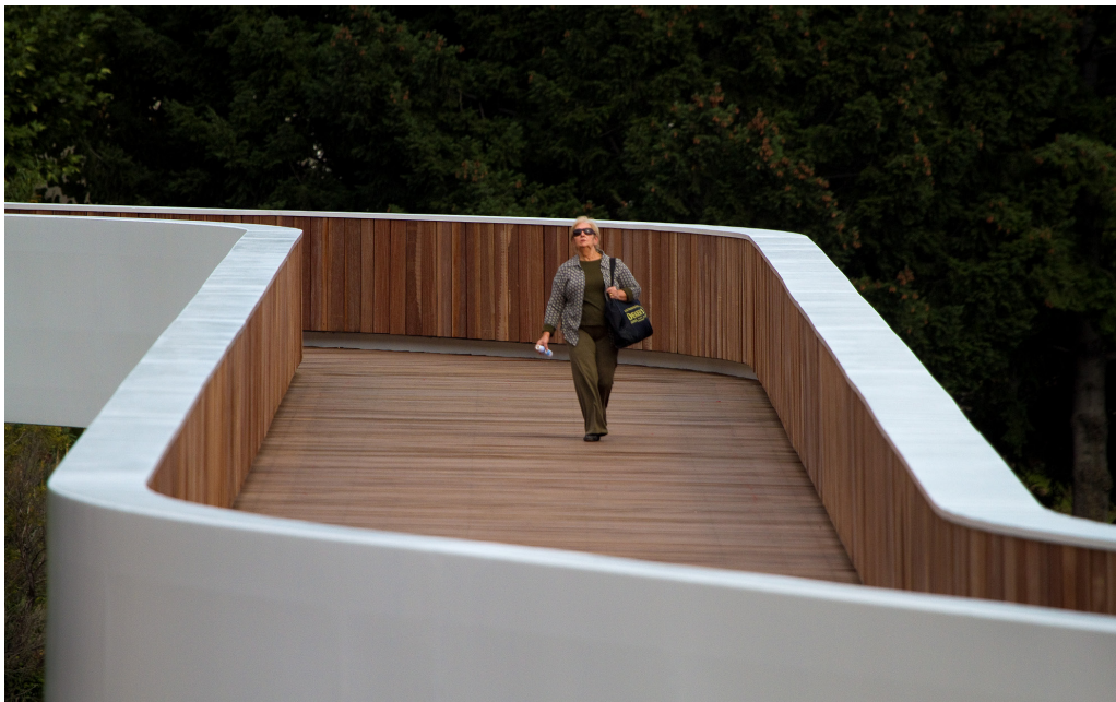
Passerelle pédestre qui enjambe la Ribeira da Carpinteira, Portugal - Carrilho da Graça Arquitectos
