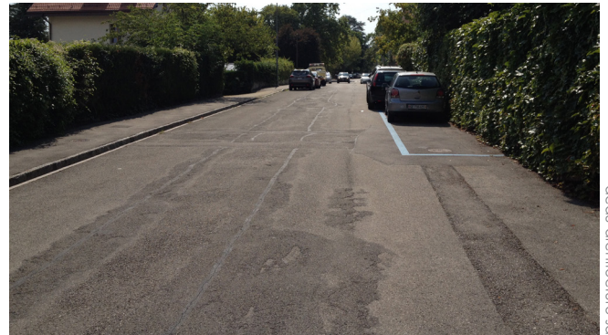
Desserte de quartier à caractère routier : ch. du Banc-Béniit
