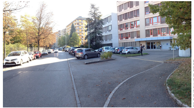
Desserte de quartier à caractère routier : l'av. Eugène Lance
