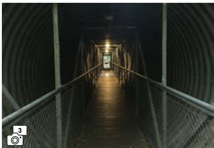
Vue d'un tunnel le long de la promenade du Voiret.
