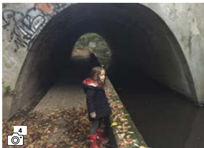
Vue d'un tunnel le long de la promenade du Voiret.
