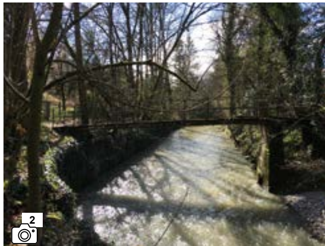
Vue de la passerelle existante.
