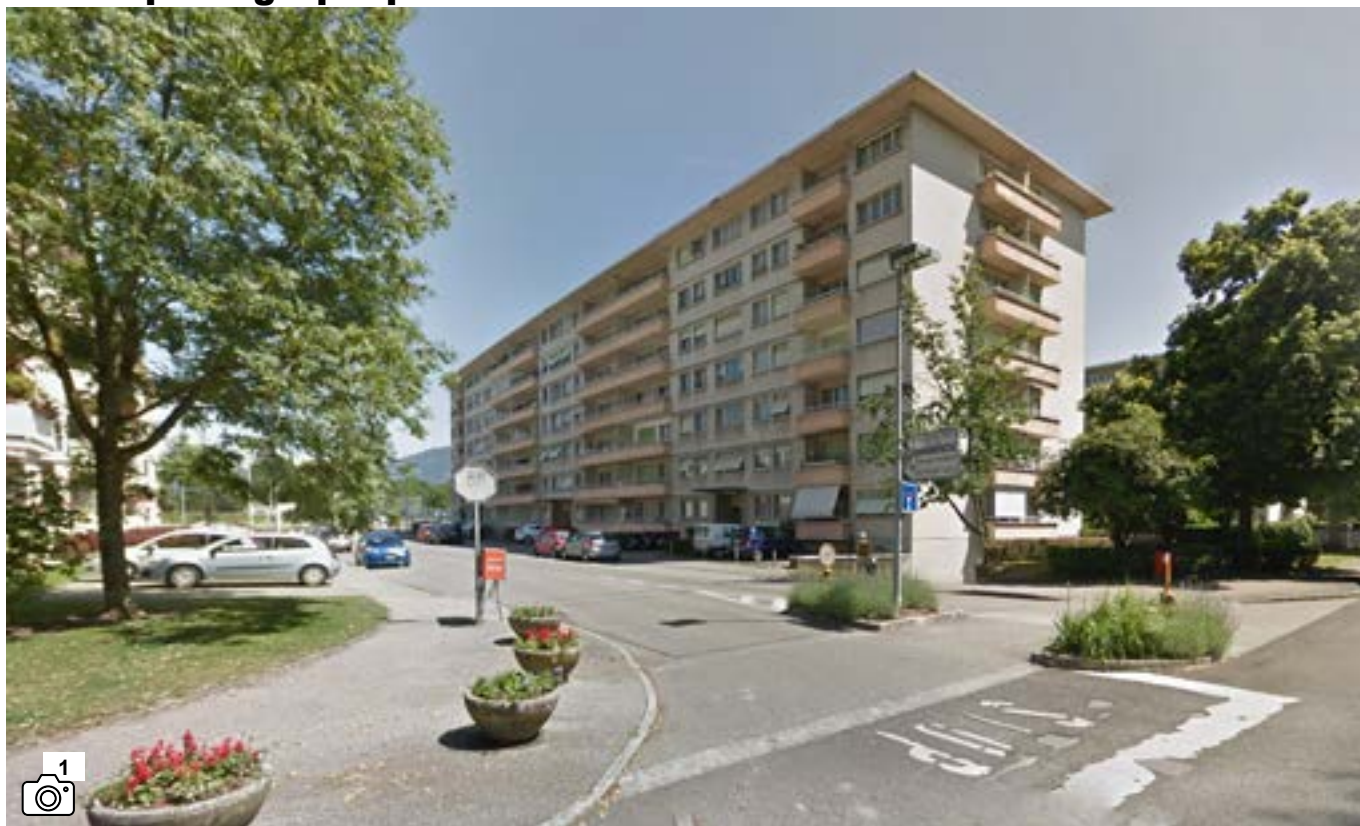
Carrefour au chemin des Semailles, absence de marquage au sol pour un passage piéton.
