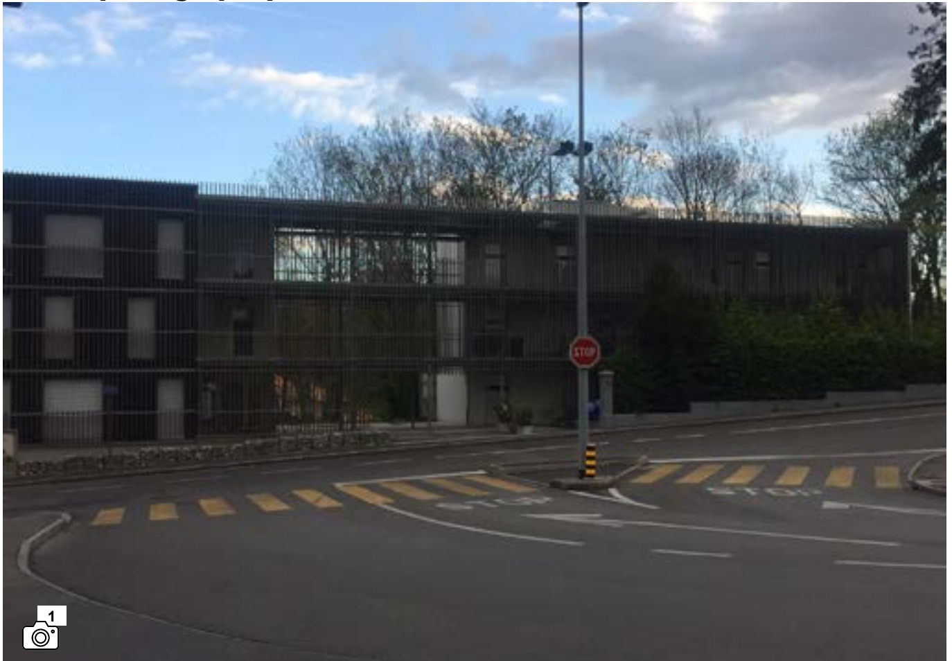
Vue sur la zone de conflit, positionnement dangereux de la ligne de stop.
